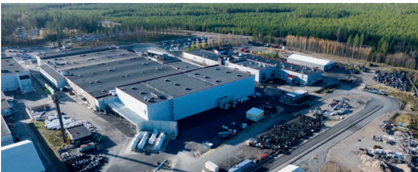
Växellådstillverkningen ligger mellan ingenjörscentret och monteringsfabriken. Även utomhusområdena har designats om, tack vare den nya porten i norr har lastbilstrafiken runt fabriken minskat till mindre än hälften.
